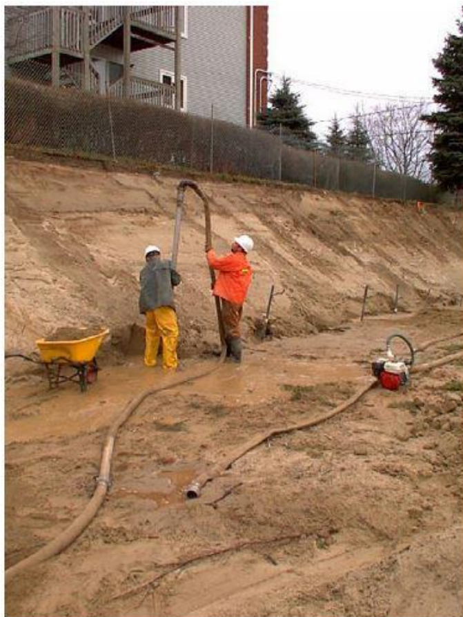
شکل ۴-۴- نصب دستی چاه خشک‌اندازی به روش حفرآبی. در سمت راست این چاه، چند چاه نصب شده قابل مشاهده است.
